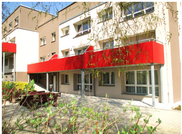
Die neu sanierte Begegnungsstätte, Barlachstraße
